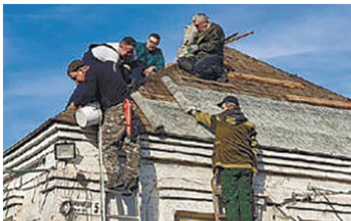
Волонтеры восстанавливают крышу дома
